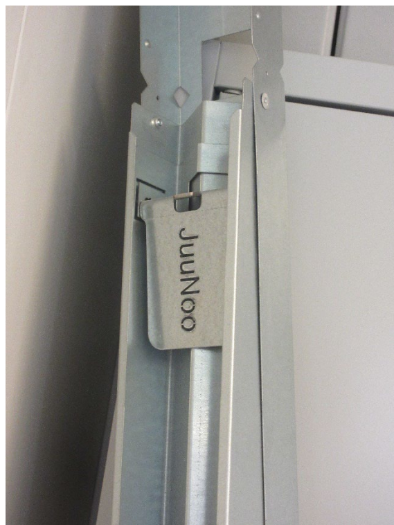
Quickspan 175 [11] dans un profilé extensible 175 [10].
