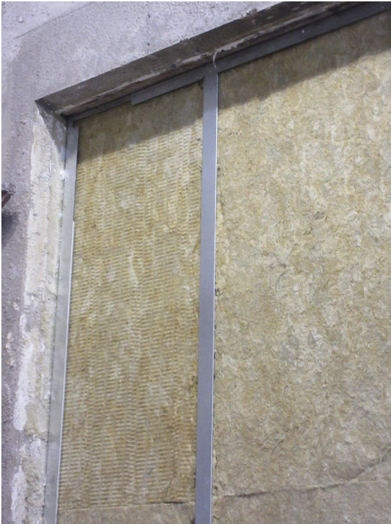
Isolation [15] dans le mur.
