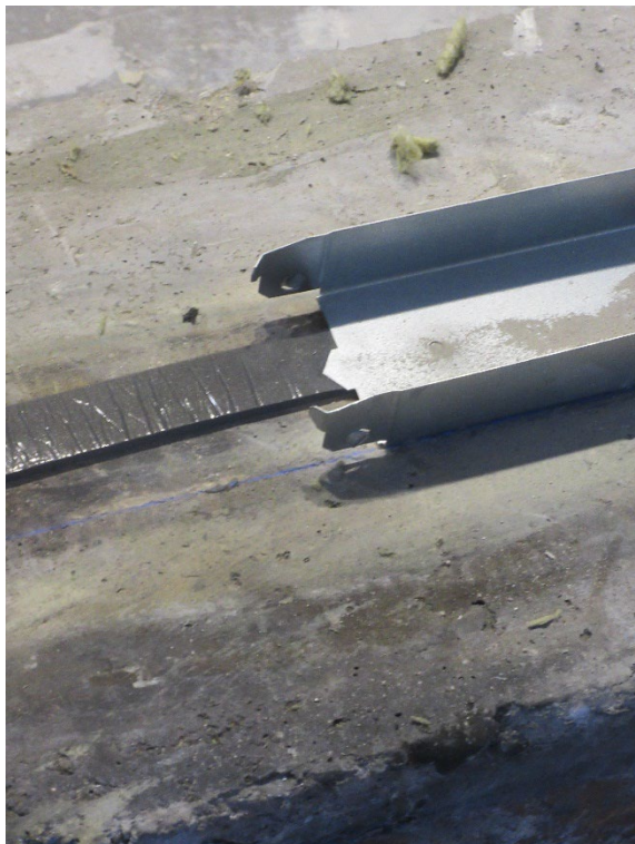
Profilé inférieur 175 [3] sur la bande d'étanchéité [9].
